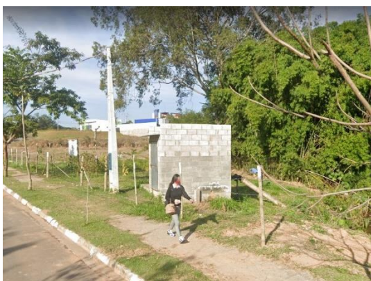
Figura 19. Casa de Bombas da EEAB da captação do Rio Capivari.
