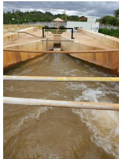
Figura 25. Aplicação de Coagulante na Calha Parshall.
