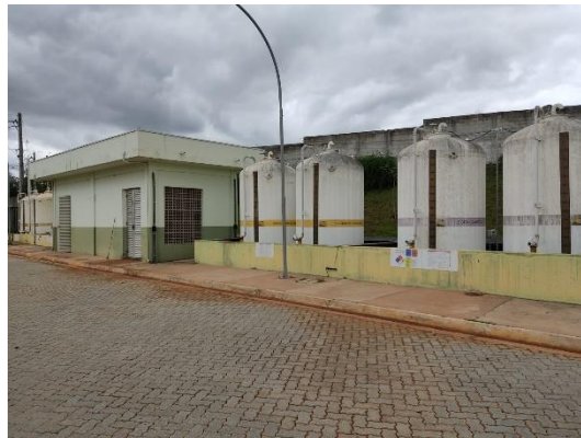
Figura 38. Casa de Química e Tanques para Estocagem.
