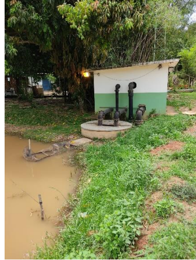
Figura 11. Tomada d'água da captação do barramento do Córrego Água do Buracão.
