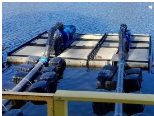
Figura 9. Tomada d'água da captação do barramento do Córrego Fetá.
