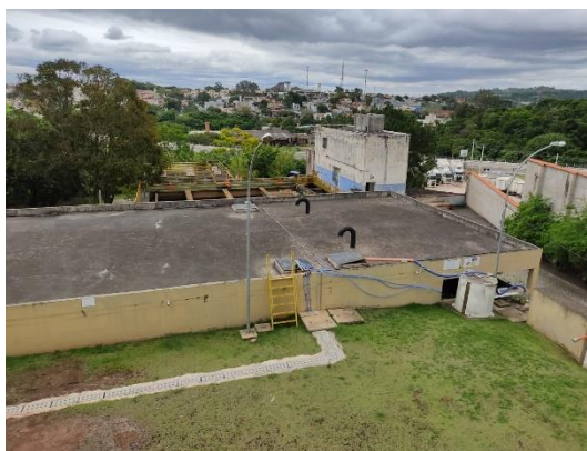
Figura 36. Tanque de Contato
