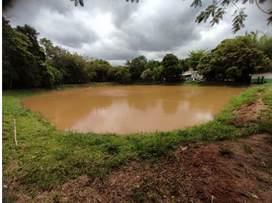
Figura 10. Barramento do Córrego Água do Buracão.
