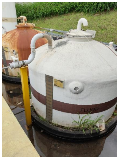
Figura 42. Tanques de Ácido Fluossilícico.
