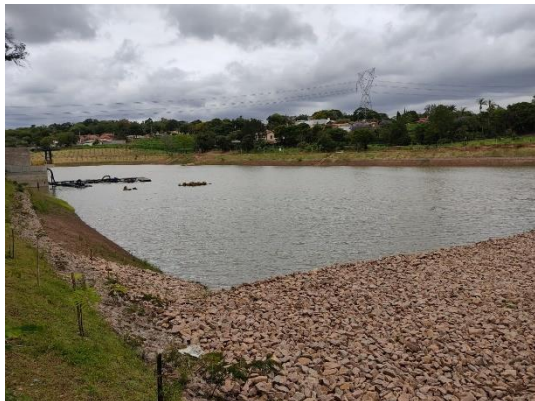
Figura 8. Barramento da captação do Córrego Fetá.
