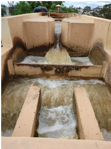
Figura 24. Calha Parshall.
