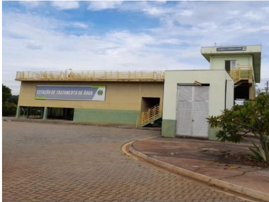
Figura 32. Estação de Tratamento de Água - ETA II.
