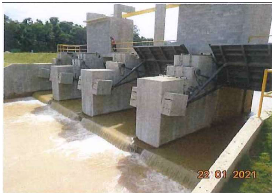
Foto 2.2 - Vista do Vertedouro por jusante.
