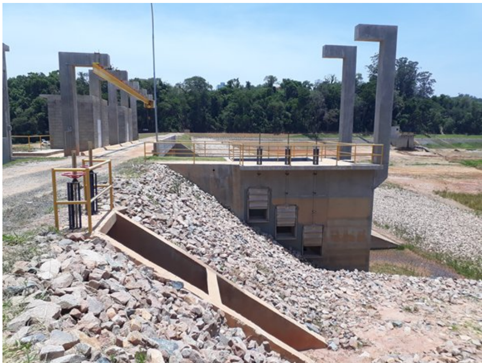
Foto 9. Vista da tomada d'água seletiva. Notar as três comportas em diferentes níveis. Em primeiro plano a saídas da escada para peixes.
