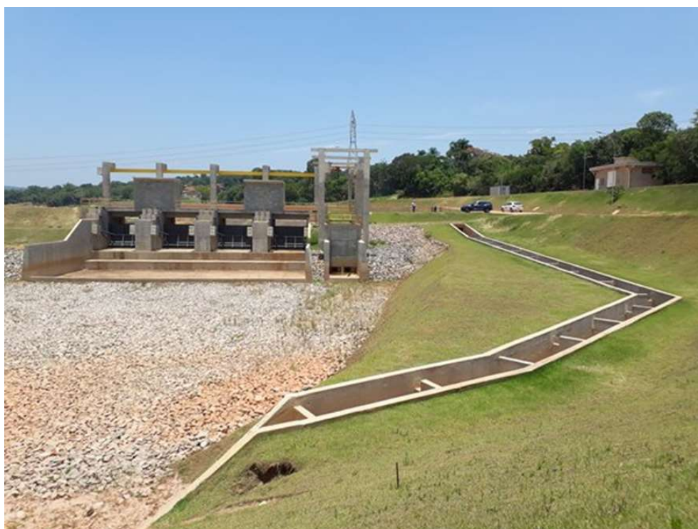
Foto 7. Vista do Vertedouro por jusante. As quatro comportas do vertedouro fechadas. A direita na foto a escada para peixes ( degraus tanque) e a galeria de saída da vazão sanitária.
