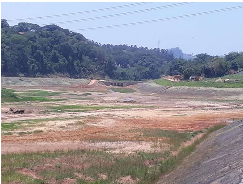
Foto 3. Vista para montante. Notar as quadro aduelas de 3m de altura e 3 m de largura na extremidade de montante do reservatório, por onde chega o córrego Fetá ao reservatório. Nas cheias elas trabalham afogadas.
