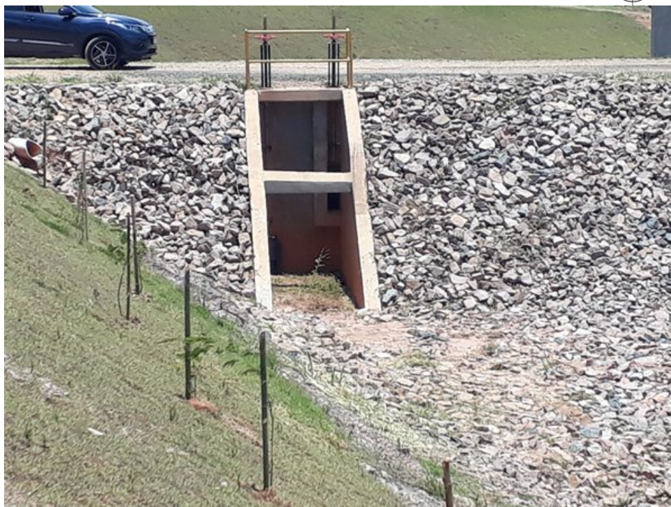
Foto 10. Vista da saída da escada para peixes. Notar os mecanismos de acionamento das comportas de controle.
