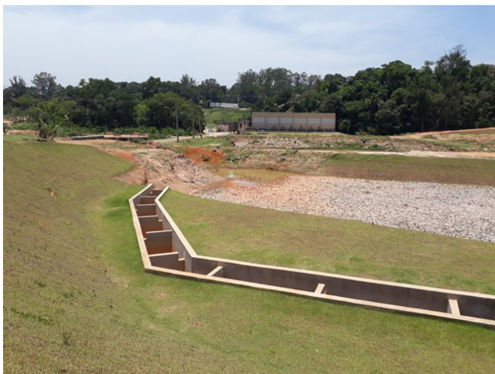
Foto 11. Vista de Trecho da escada para peixes e do canal de restituição do vertedouro parcialmente construído.
