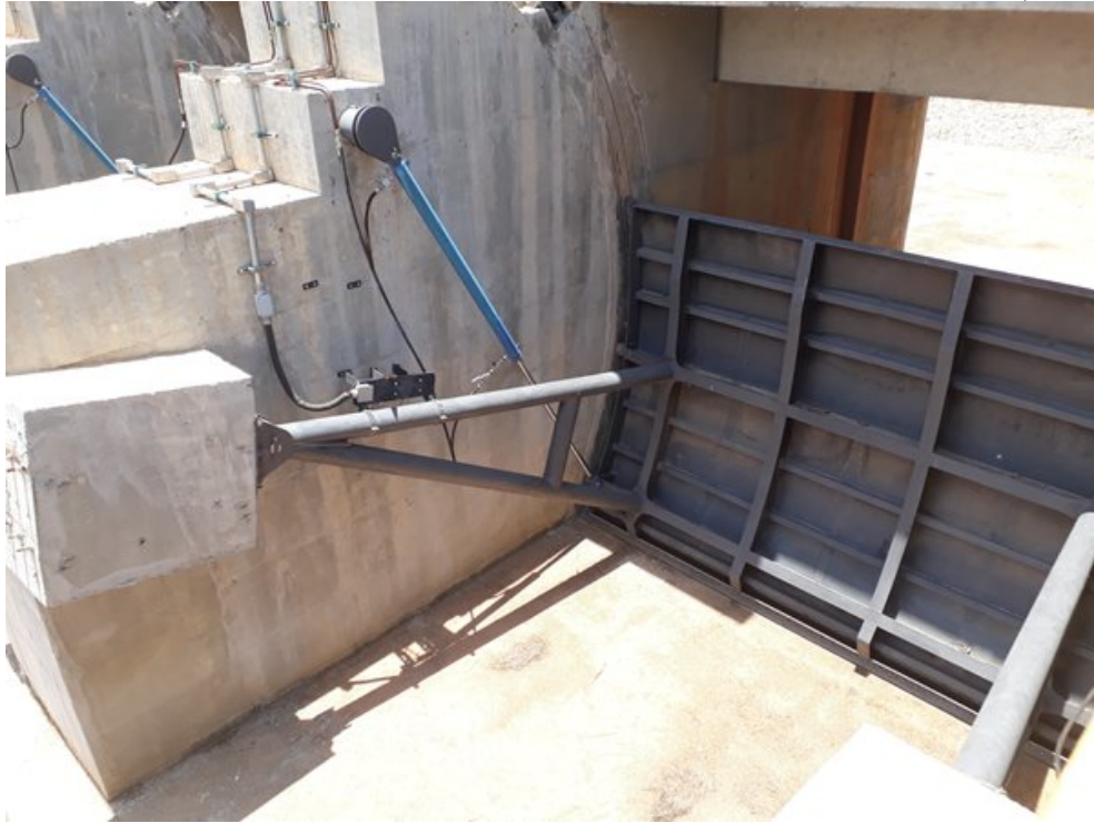
Foto 8. Detalhe da comporta do vertedouro.
