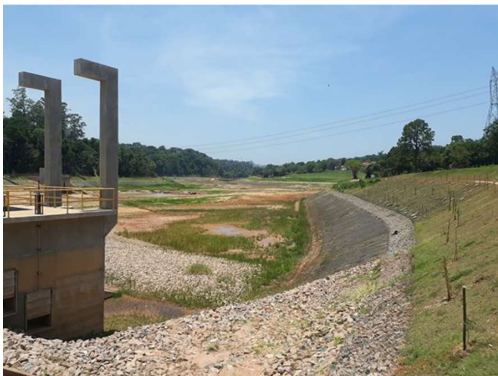
Foto 1. Vista para o Reservatório de jusante para montante. Notar que ele se encontra vazio. Proteções íntegras na margem.
