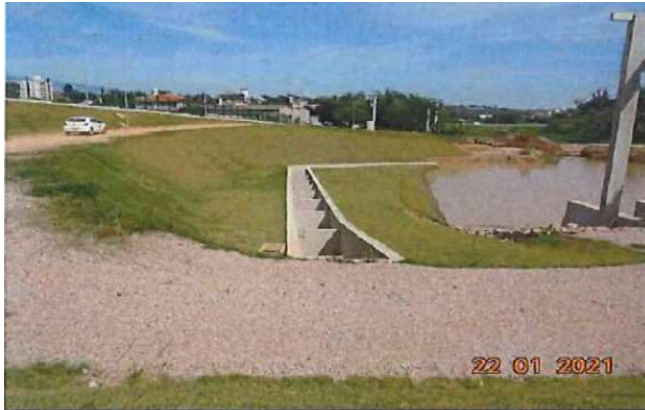
Foto 2.3 - Vista para jusante da Escada para Peixes.
