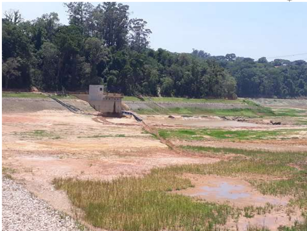
Foto 2. Vista da Estação de bombeamento que direciona a água que chega ao reservatório para a ETA. Tem um canal escavado que leva a água da extremidade de montante do reservatório para a depressão escavada para a colocação das tubulações de adução.
