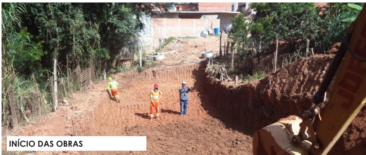
INÍCIO DAS OBRAS
