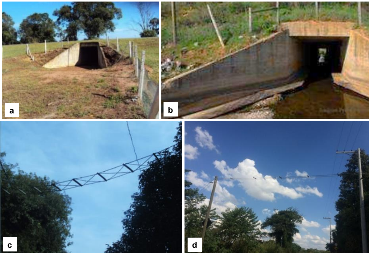
Figura 9.4.5.1. Exemplos de passagem de fauna. a. Passagem tipo caixa seca, acompanhada de cerca (Foto de F. D., extraída de Abra 2012, rodovia SP-225, Brotas, SP). b. galeria de concreto com passarela permanente em ambos os lados da passagem (Foto de F. D. Abra, extraída de Abra, 2012; Alentejo, Portugal). c. Passagem aérea para animais arborícolas (Foto de J. C. G. Fagundes, extraído de Teixeira et al., 2013; Porto Alegre, RS), d. Passagem aérea para animais arborícolas (Foto de F. M. de A. Rollo, presente trabalho; Louveira, SP).
