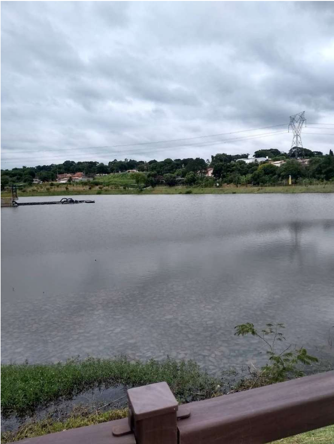
Imagem 14 – Assoreamento da Barragem do Córrego Fetá
