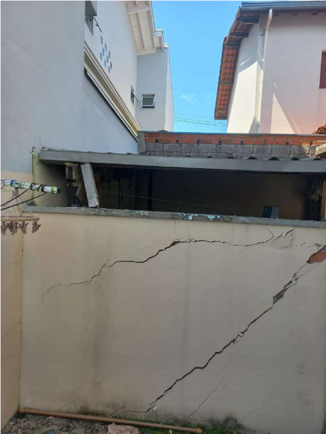
Imagem 15 – Vistoria Preventiva em Imóvel – Jardim Serra Azul
