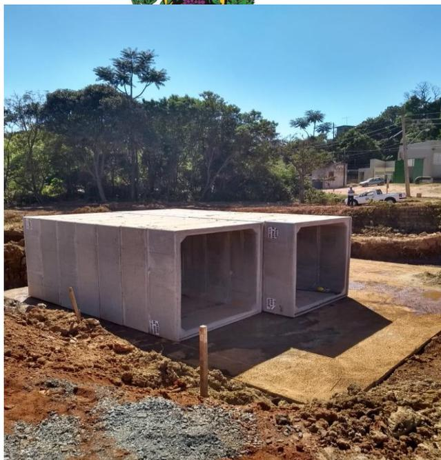
8- Conclusão da travessia de águas pluviais do centro para melhorar a drenagem superficial na área central.
